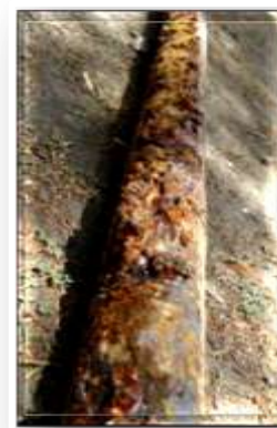
Detección de fugas en la red
