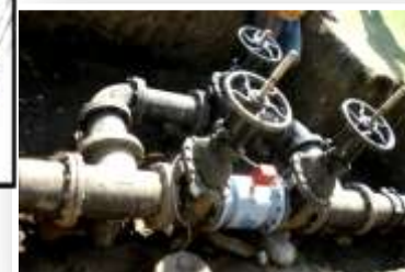
Instalación de medidores en la red
