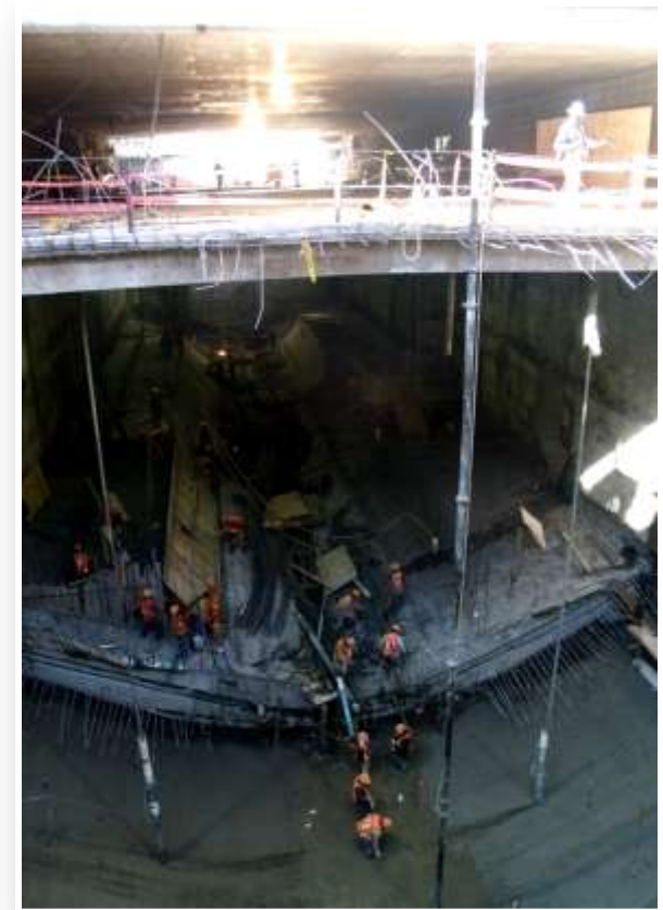
Construcción de la estación Mexicaltzingo de la Línea 12
