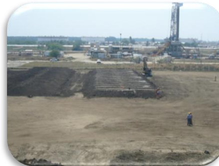
Construcción y terminación de las biopilas
