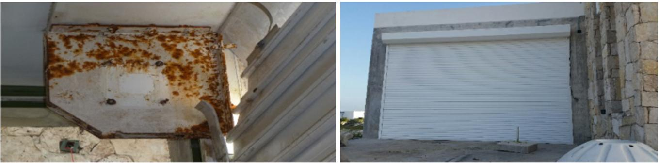
Figura 8.7. Archivo fotográfico de ventanas y persianas anticiclónicas deterioradas y nuevas.
