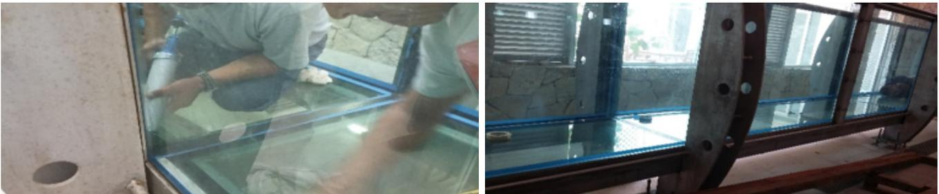
Figura 8.8. Archivo fotográfico de proceso de reparación de sellado de canal de olas.
