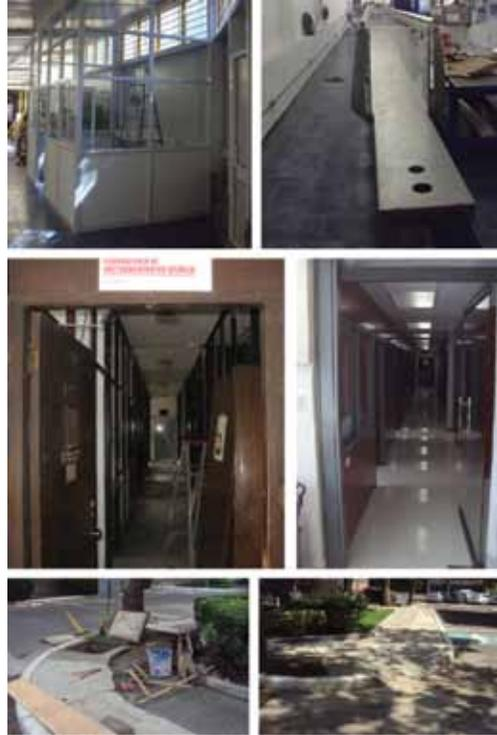
Figura 8.1. Algunas actividades de mantenimiento realizadas en el IIUNAM durante 2012. (a) Habilitado de cuarto de control en canal de olas secundario ubicado en E-8. (b) Remodelación del Laboratorio de Instrumentación Sísmica en el sótano del E-1 (antes y después). (c) Mejora de la accesibilidad a los edificios del Instituto.
