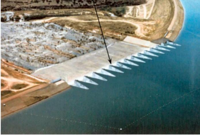
Figura 3.20 Vertedor de laberinto, Ute Dam, New Mexico. (USBR, 2014).
