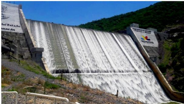
Figura 4.26 Aireador del vertedor de la presa Centenario de la Revolución Francisco J. Mújica.
