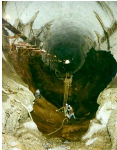
Figura 4.2 Daño por cavitación (11 m) en el vertedor izquierdo de la presa Glen Canyon, septiembre de 1983.
