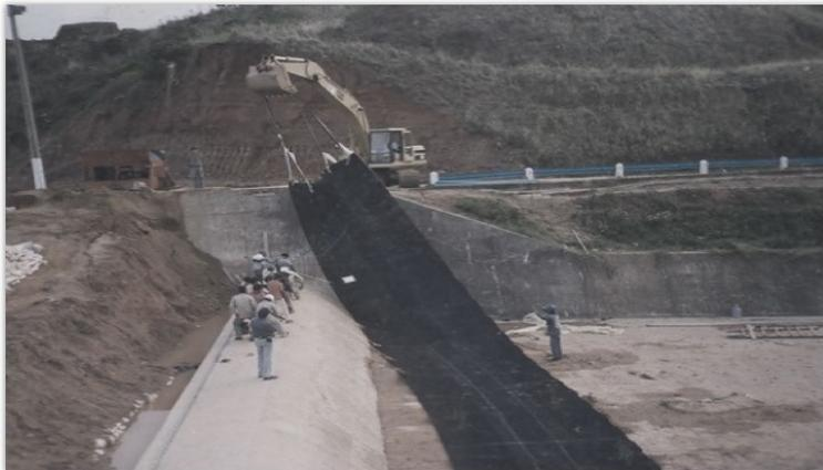
Figura 1.68. Colocación del dique inflable de una pieza en la presa La Cangrejera
