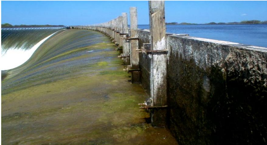
Figura 3.8 Colocación de agujas en la presa Marte R. Gómez, El Azúcar. Tamaulipas.
