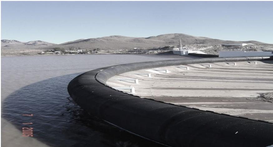
Figura 1.71. Dique inflable, "rubber dam" sobre el vertedor de eje curvo de la presa Francisco I. Madero, Chih.
