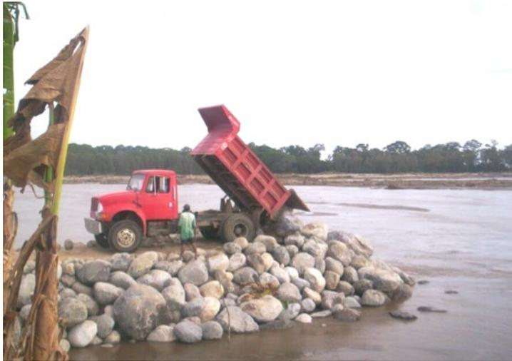
Figura 2.31 Cierre lateral mediante el empleo de camiones a volteo
