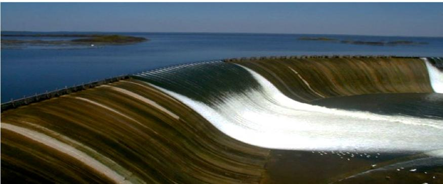
Figura 4.1 Fenómeno de aguas blancas en un vertedor de abanico.
