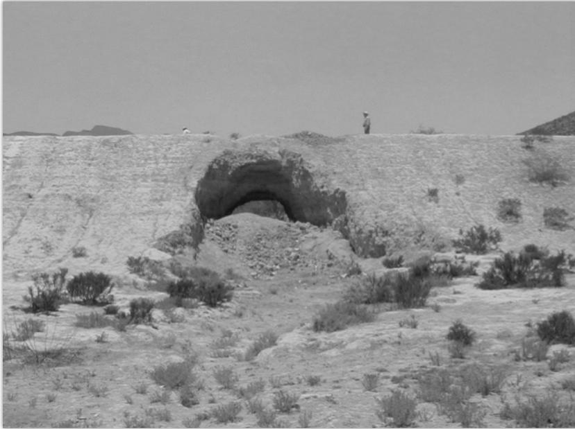
Figura 1.80. Tubificación en una presa de sección homogénea.
