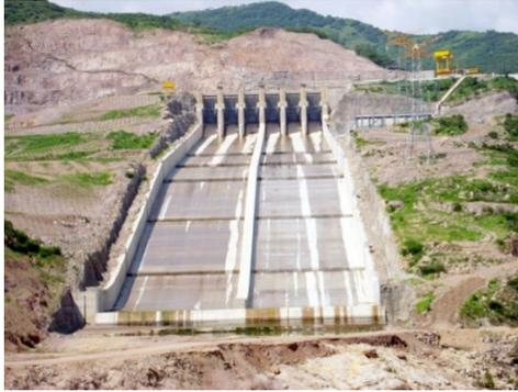
Figura 4.25 Aireadores de los vertedores del PH el Cajón
