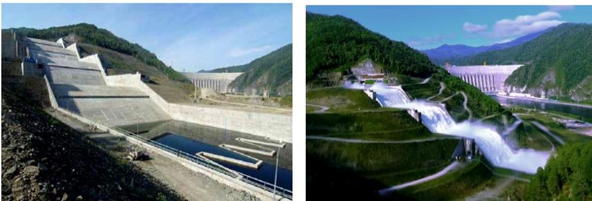
Figura 3.88 Vertedor escalón a escalón construido en la central hidroeléctrica Sayano-Shúshenskaya, sobre el Río Yeniséi, en Siberia-Rusia, (Sandoval W., 2018).
