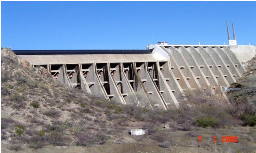
Figura 3.2 Presa inflable plástica, “rubber dam” sobre la presa Francisco I. Madero Chihuahua, México.
