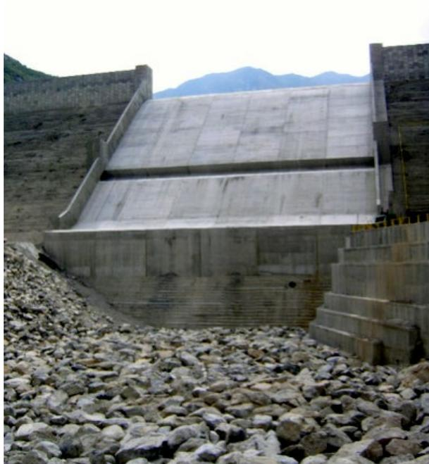
Figura 4.24 Aireador del vertedor de la presa Corral de Palmas en el Estado de Nuevo León.
