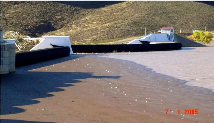
Figura 3.10 Presa inflable plástica, "Rubber Dam", sobre la presa Francisco I. Madero Chihuahua
