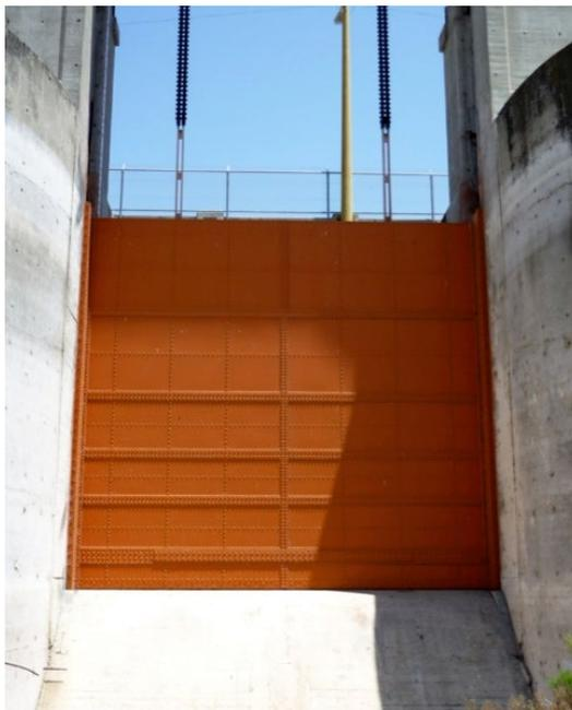
Figura 3.7 Compuerta deslizante, sobre el vertedor de la presa Abelardo L. Rodríguez, B. C.
