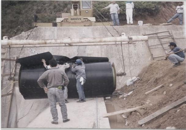
Figura 1.67. Colocación del dique inflable de una pieza en la presa La Cangrejera
