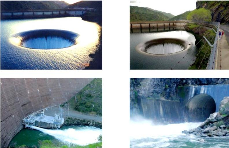
Figura 3.79 (b) Vertedor de embudo de la presa Monticello.
