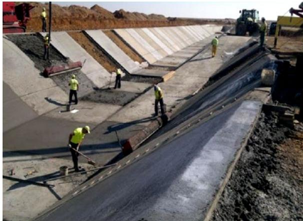
Figura 3.102 Colado de losas en un canal revestido.
