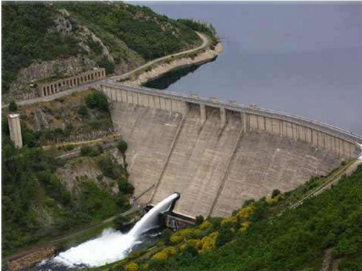
Figura 1.9. Desagüe de fondo en una cortina de gravedad. Confederación Hidrográfica del Duero.
