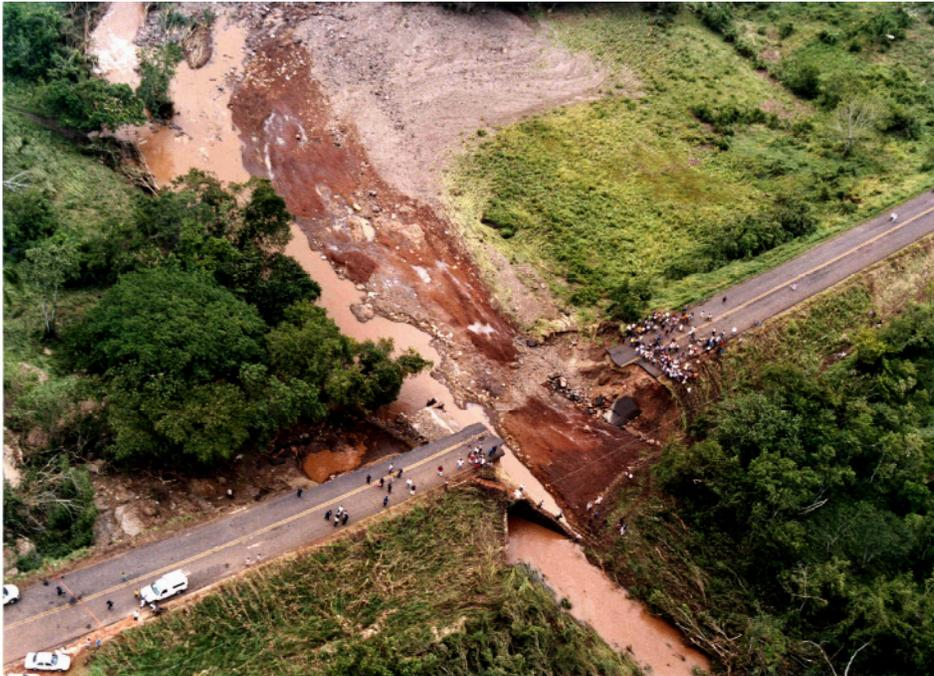
Foto 5. Puente fracturado por Stan en San Miguel, municipio de Acayucan (foto cortesía de la Subsecretaría de Protección Civil del Gobierno del Estado).
