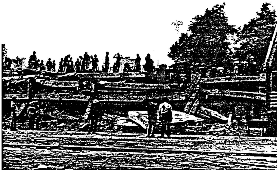
Colapso de edificio por pérdida de capacidad de carga vertical Failure of a building through loss of capability of vertical load
