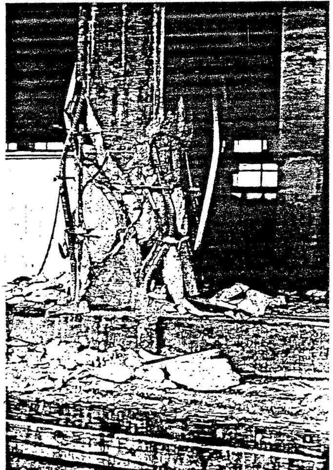
Falla de columna por cortante y carga axial
