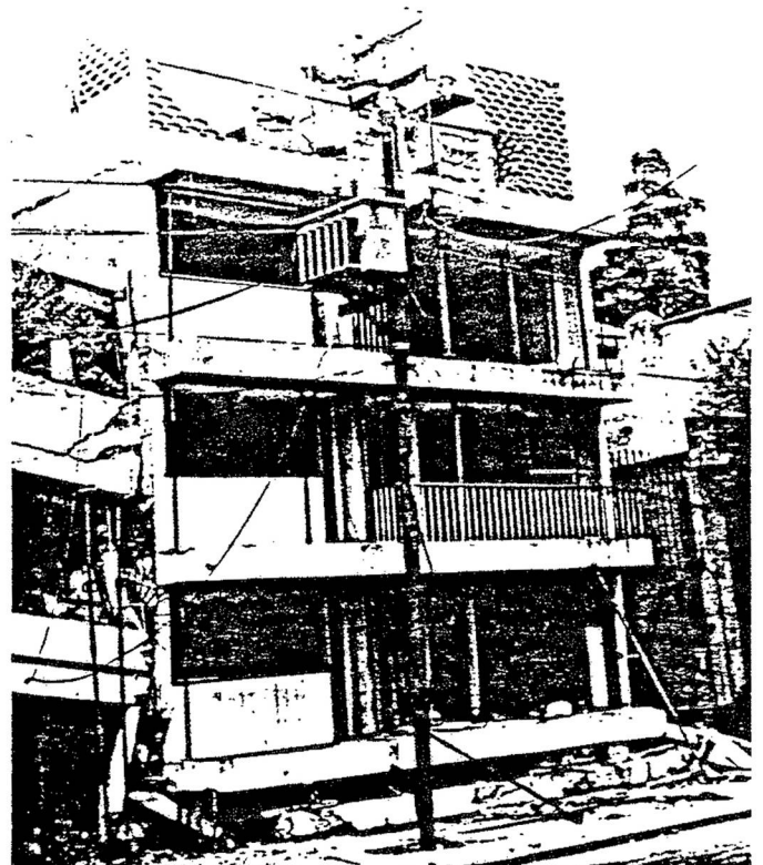
Colapso de planta baja débil
