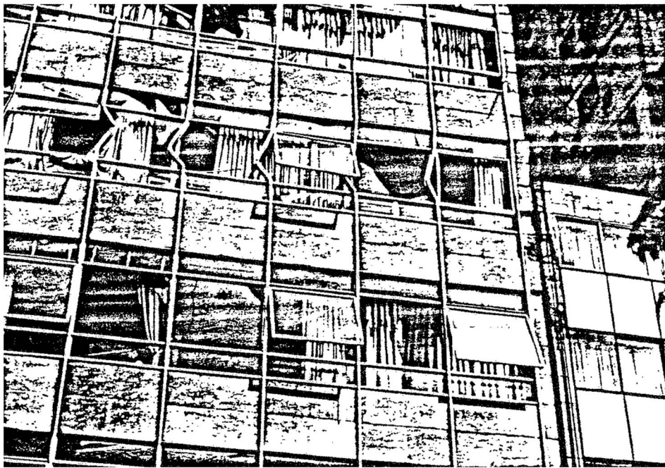
Falla de un entrepiso probablemente propiciada por choque con el adyacente
