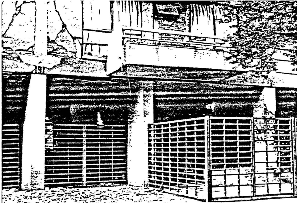
Falla en columnas de edificios con planta baja débil Failure in columns of buildings with a weak ground floor
