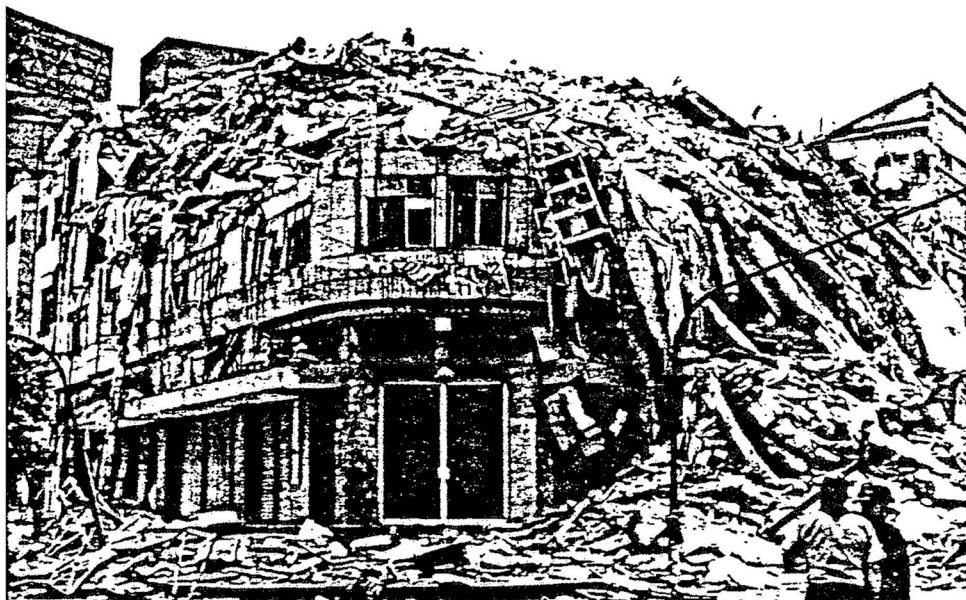
Distribución asimétrica de muros de mampostería en edificios en esquina Asymmetric distribution of masonry walls in corner buildings
