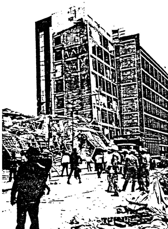
Inclinación de edificio por hundimiento Leaning of building through settlement
