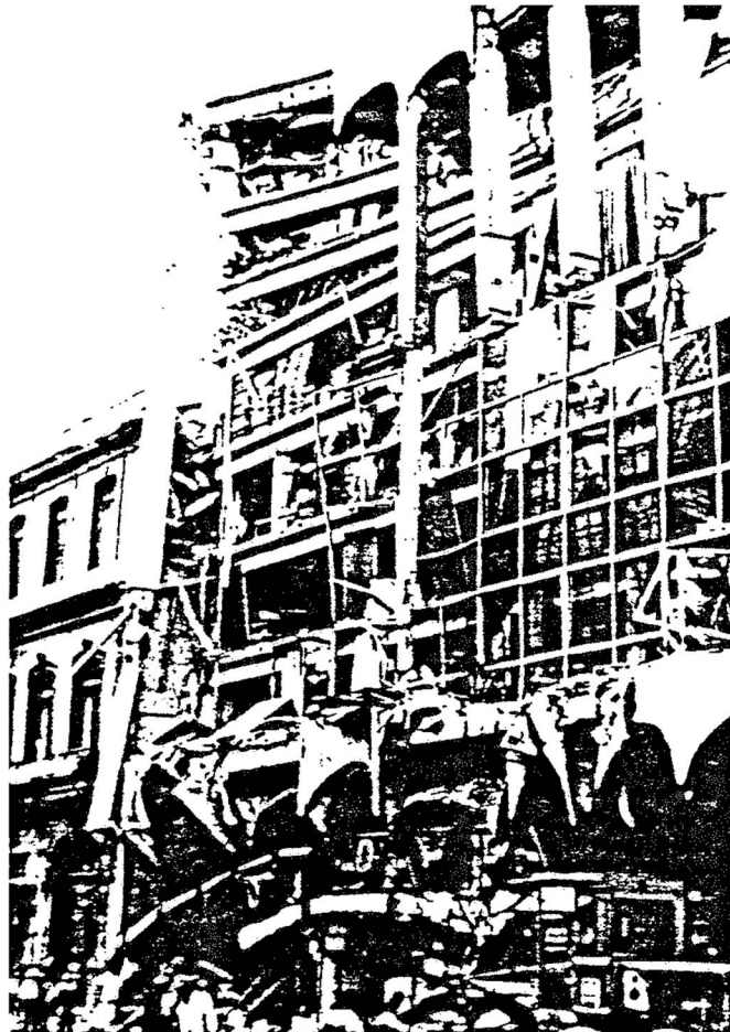
Sobrecarga excesiva en pisos superiores Excessive overload in the upper floors
