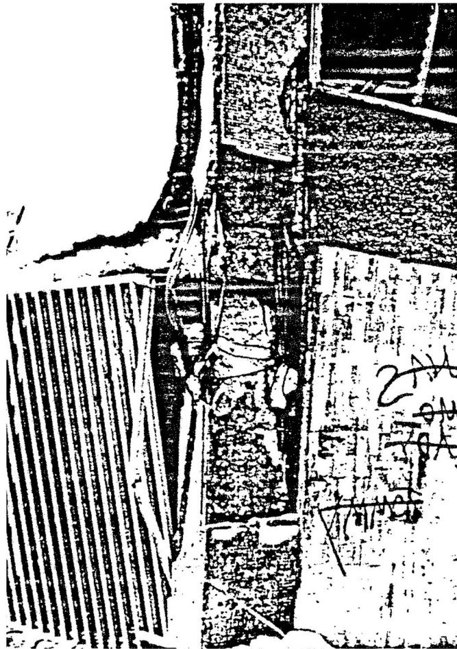
Falla de columna con escaso confinamiento lateral Failure of column due to lateral confinement
