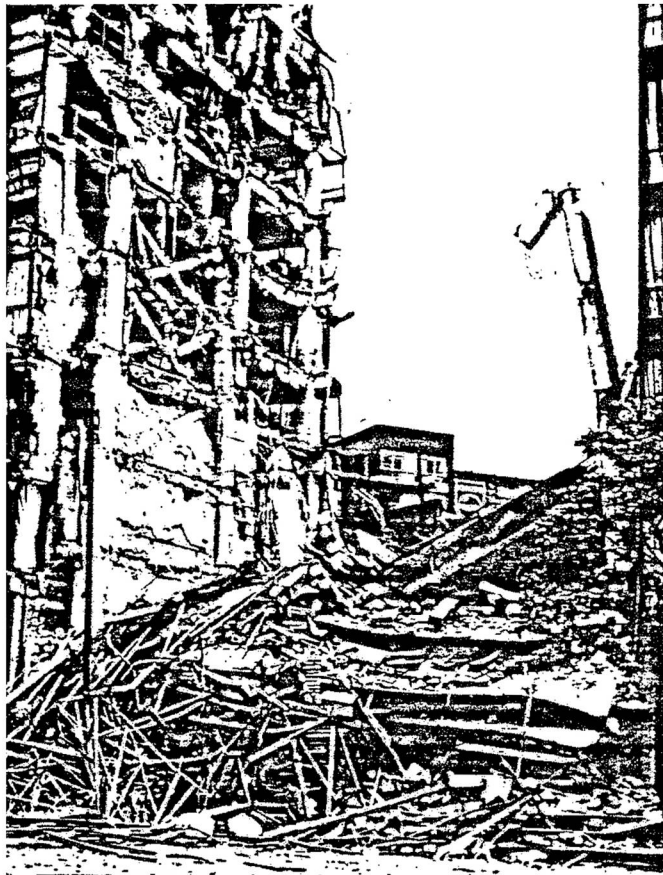
Colapso por punzonamiento de losas reticulares Collapse through punching of waffle slabs
