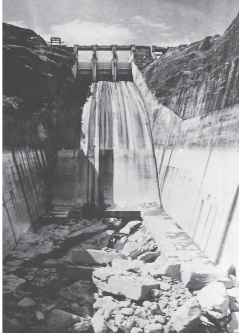
Tanque amortiguador del vertedor de la presa Malpaso dañado (1971). Archivo histórico del II.
