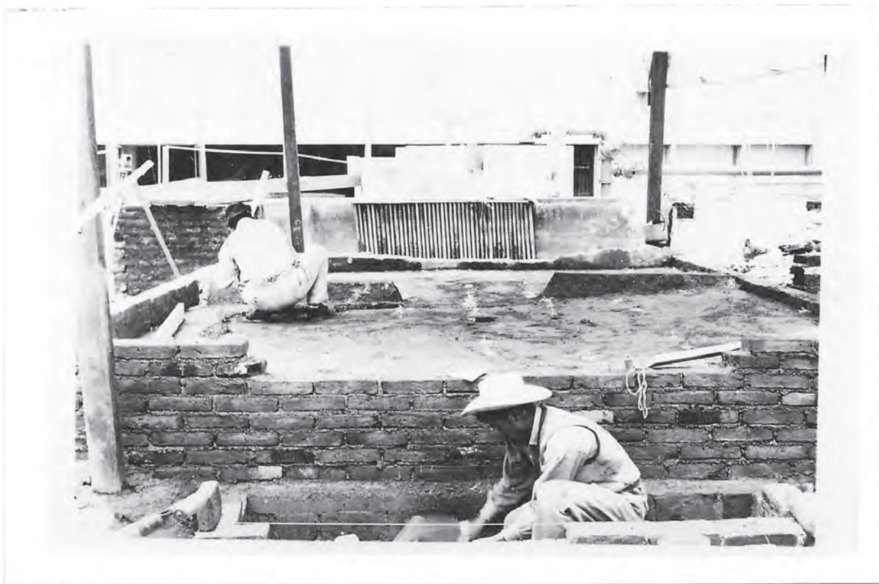
Construcción de un modelo hidráulico en el primer laboratorio de hidráulica del II, ubicado a un costado del Instituto de Geología (hoy CELE), 1957.
