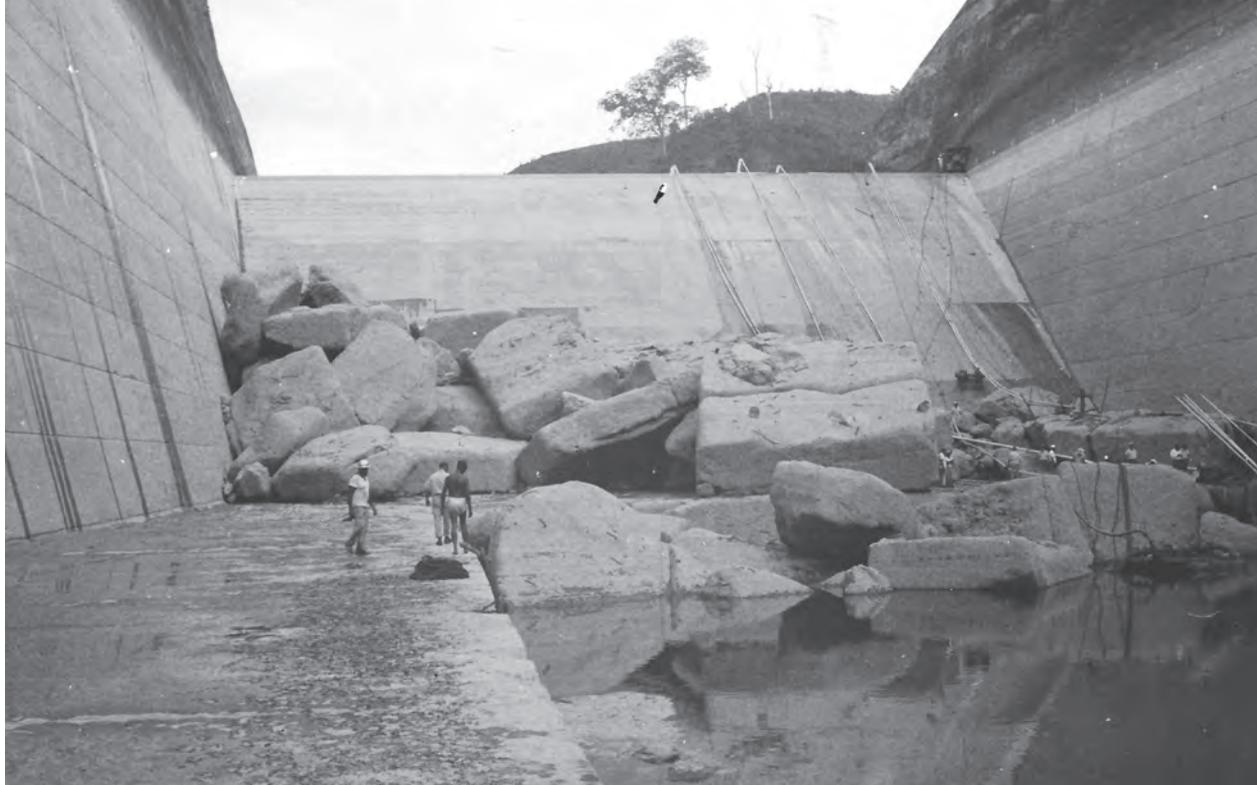
Losas depositadas en la rampa de salida con la cara inferior vuelta hacia arriba (1971). Archivo histórico del II.
