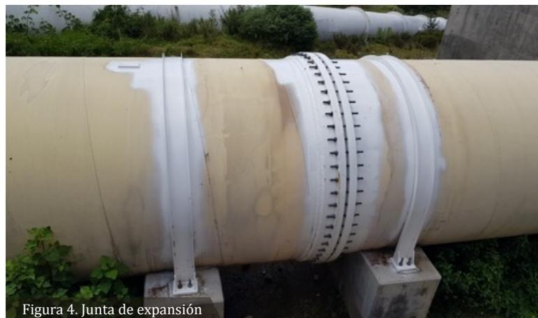
Figura 4. Junta de expansión
