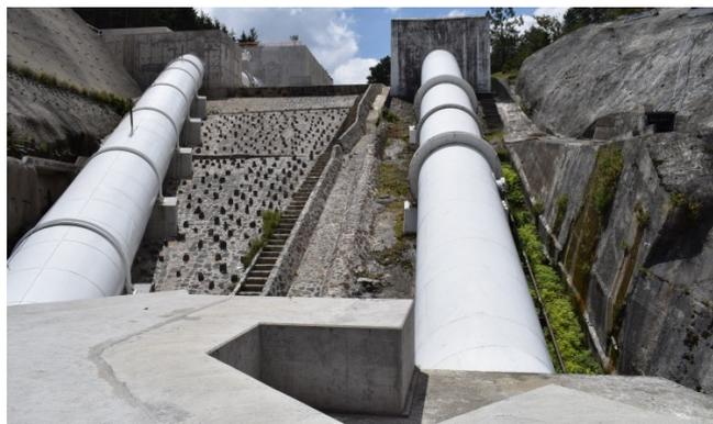
Figura 1. Tuberías de alta presión en la descarga de la Planta de Bombeo No. 5
