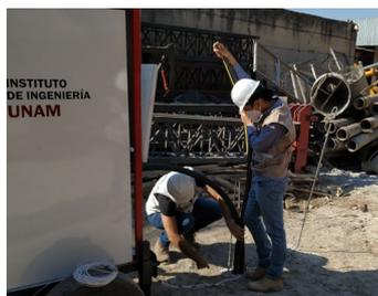
d) Corte de la tubería y colocación del aislante térmico
